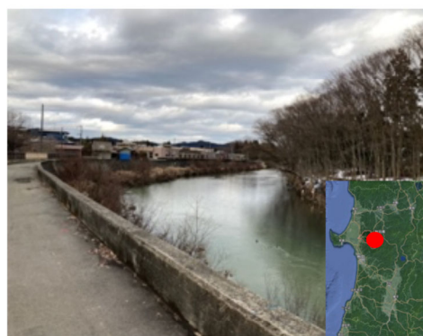
Fig.1 溢水した五城目町の馬場目川 (右岸(図中左)の堤防を溢水)
